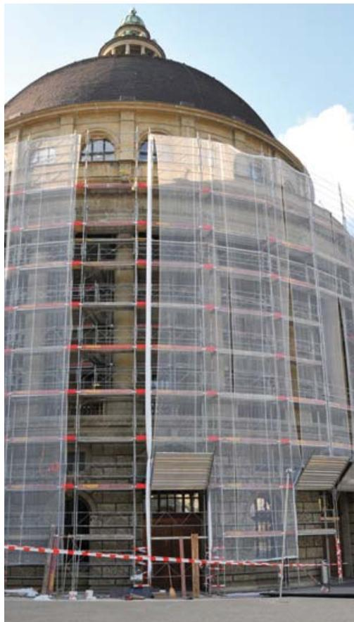
Der Rundbau des Hauptgebäudes ist für Sanierungsarbeiten eingerüstet. (Bild Lars Gubler/ETH Zürich)
